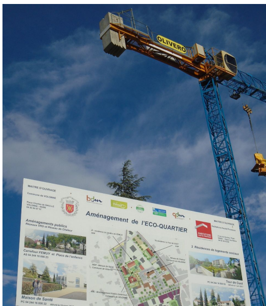
Construction de la maison de santé de Volonne
